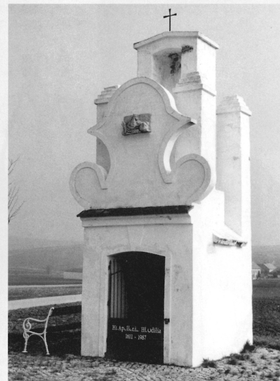
Die Straße von Herzogbirbaum nach Großmugl hat man verlegt und dort auch die „Apolloniakapelle“ wieder aufgebaut.
